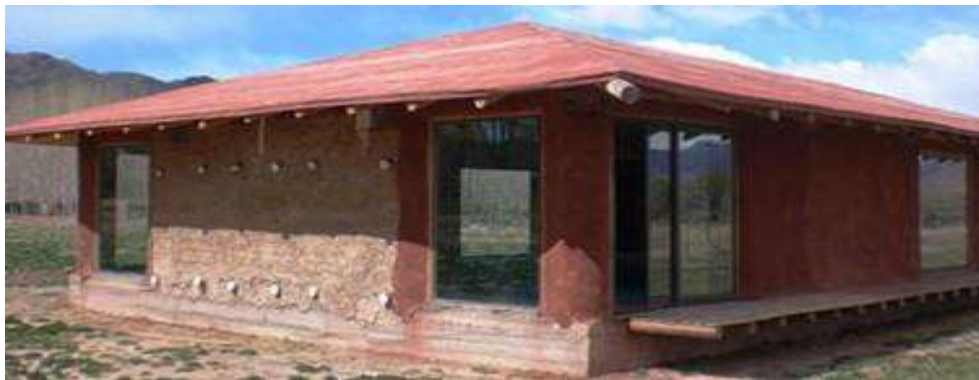
Figura 3: Vista lateral Noroeste del SUM.
