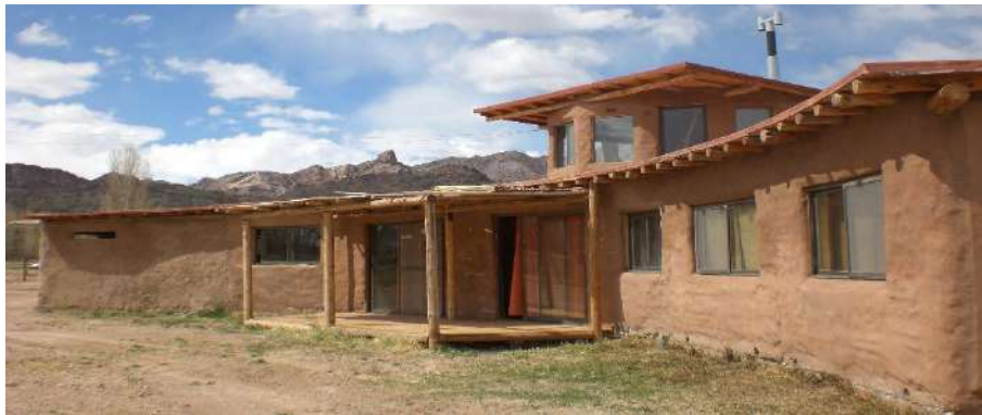
Figure 5: Frente Norte de la vivienda unifamiliar.
