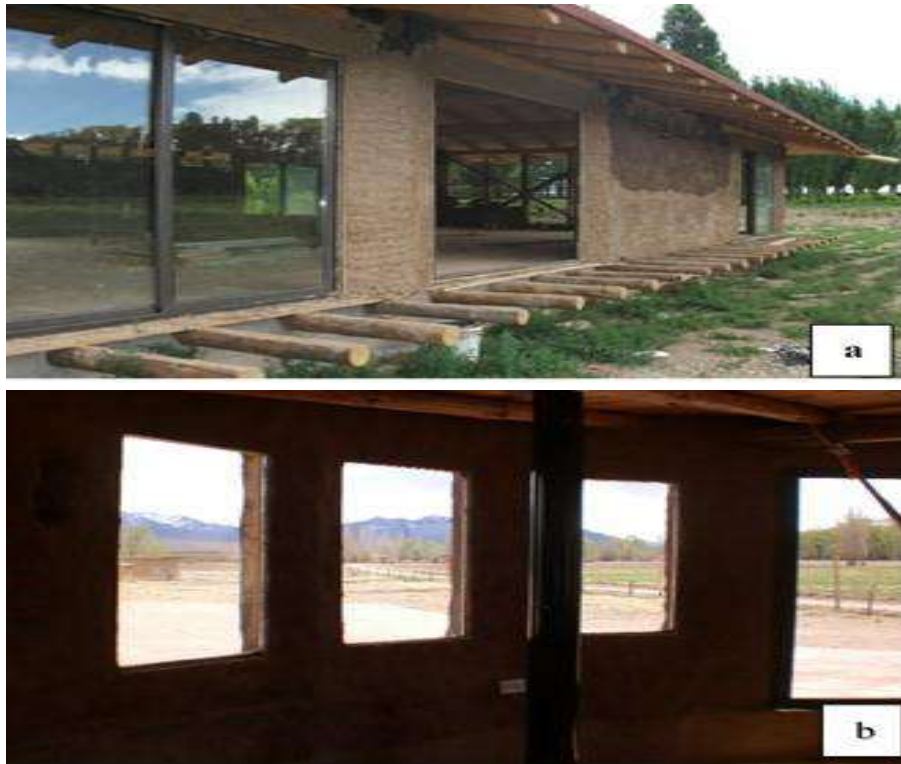
Figura 6: a- Ventanas de aluminio SUM. b- Ventanas de madera vivienda.
