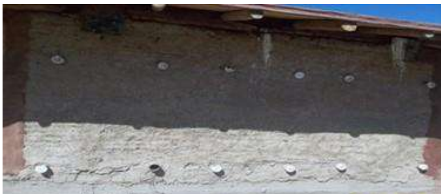
Figura 7: Muro Trombe-Michel sin el DVH exterior y con tubos de PVC.
