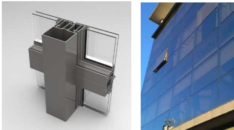
Figura 1. Imagen izquierda: Sistema de carpintería seleccionado para el estudio. Imagen derecha: apariencia exterior de un sistema “piel de vidrio”.
